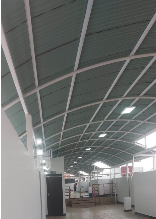
CAMBIO DE CUBIERTA Y PISOS (TERRAZA)
