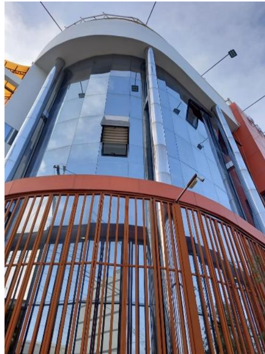
MANTENIMIENTO DE LA FACHADA DEL EDIFICIO
